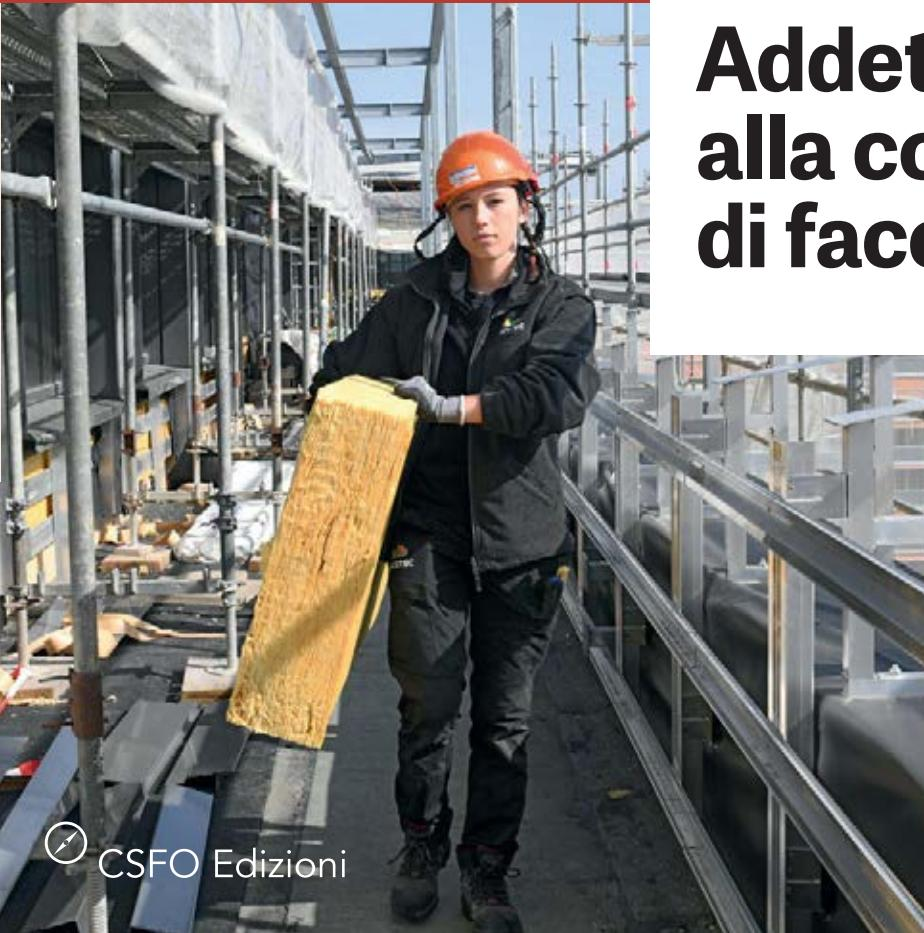
I mattoni o i materiali isolanti di un edificio si vedono raramente dall'esterno, perché coperti da lastre in fibrocemento, metallo lucido o legno. I costruttori di facciate assemblano questi componenti non solo per una questione estetica, ma anche e soprattutto per proteggere gli edifici dal caldo, dal freddo, dal vento e dall'umidità. Costruiscono dapprima le strutture portanti, installano poi l'isolamento termico e montano infine gli elementi esterni delle facciate.
