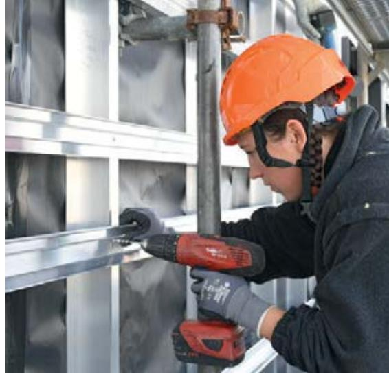
>Costruire la struttura portante Questi professionisti realizzano strutture portanti in alluminio, acciaio, legno o fibra di vetro. Esse fungono da «base» per la costruzione delle facciate.
