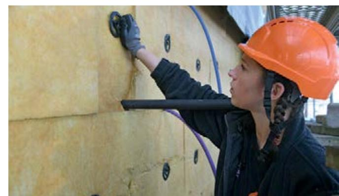
^Installare l'isolamento termico I costruttori di facciate utilizzano uno speciale sistema di fissaggio per integrare nella struttura portante l'isolamento termico nonché il materiale fonassorbente e antincendio.
