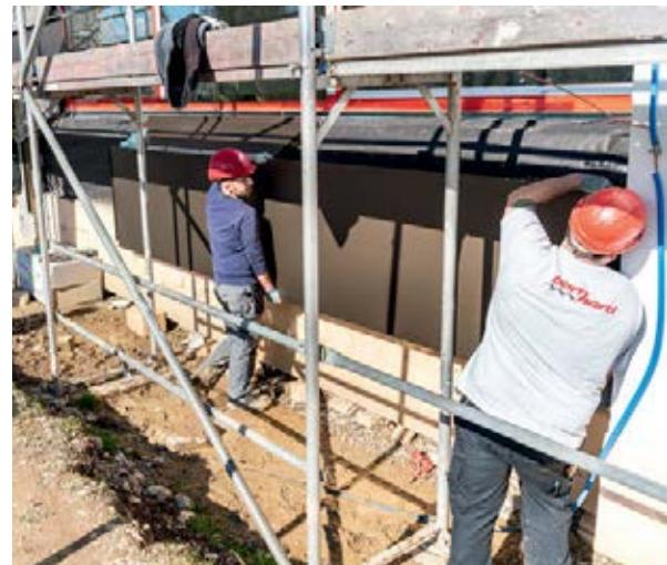
◀ Montare le lastre di rivestimento Gli elementi della facciata sono costituiti per lo più da lastre che vanno avvitate alla struttura portante.
