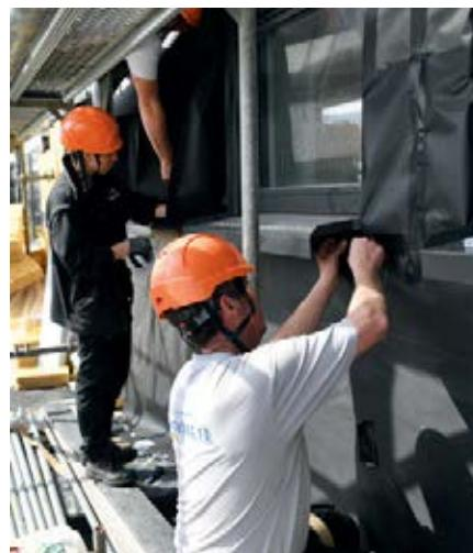
▼ Controllare le facciate Le lastre ricoprono l'intera superficie? Sono diritte e ben avvitate? Sono aspetti che è necessario controllare, utilizzando ad esempio la livella.
